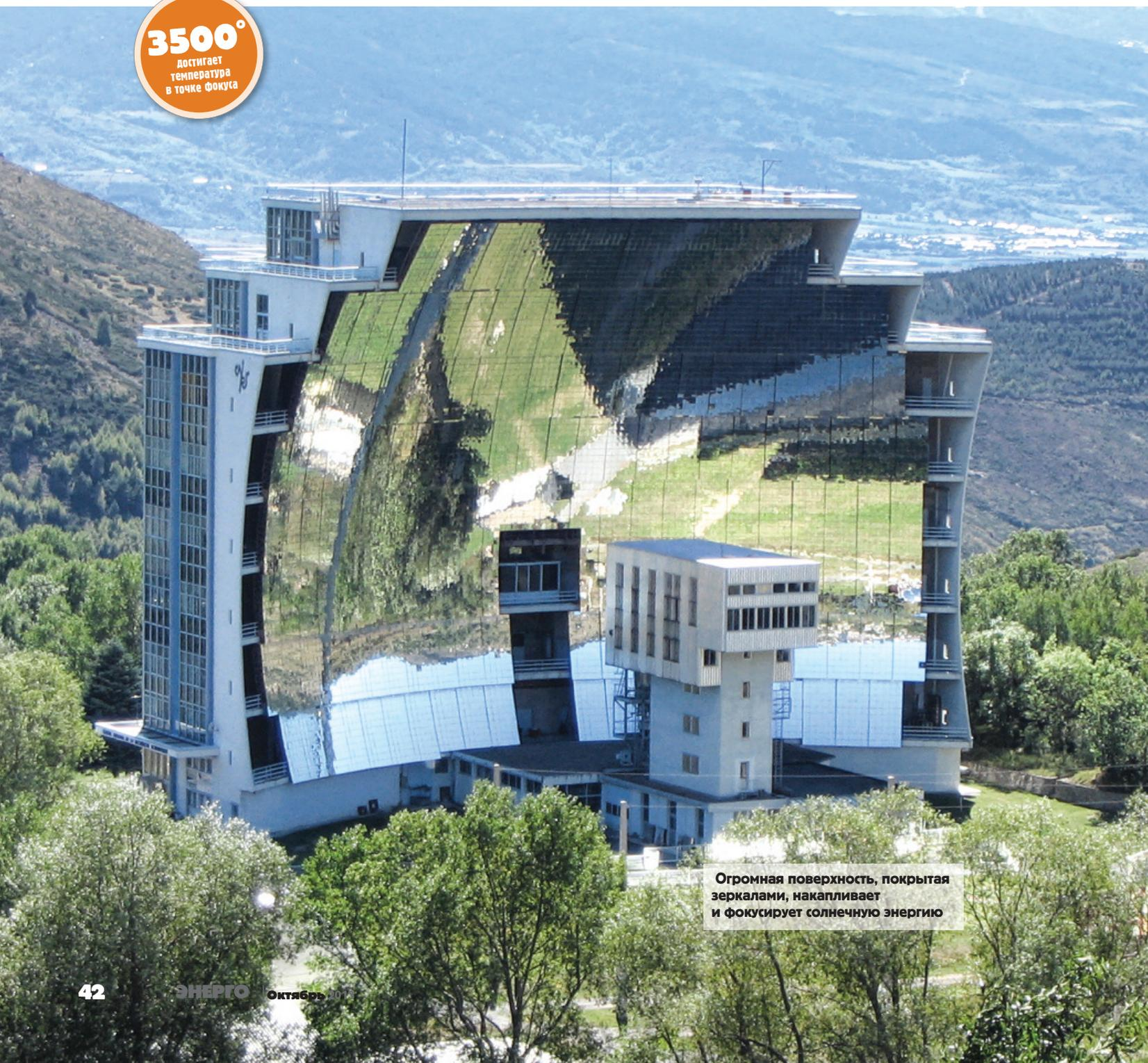
Огромная поверхность, покрытая зеркалами, накапливает и фокусирует солнечную энергию
