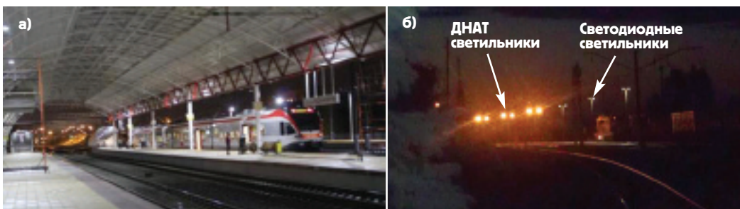
Рис. 3. Светодиодное освещение крытого перрона железнодорожной станции в г. Ждановичи (а) и открытого перрона станции Беларусь в г. Заславль (вид из кабины машиниста) (б)
