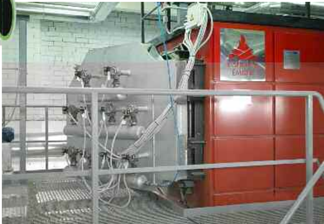
Рис. 6. Котел горизонтальной компоновки компании «ENERSTENA» устанавливается над топкой, придавая конструкции компактность. В левой части котла видна система автоматической обдувки газовых труб.
