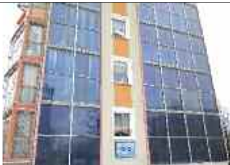
Ввод в эксплуатацию в 2000 г. фасадного коллектора площадью 77 кв. м обеспечил потребность этого дома в горячей воде на 30%
