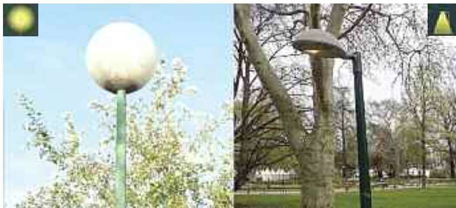
Шарообразные фонари на одной из венских улиц (слева) были заменены на светодиодные (справа)
