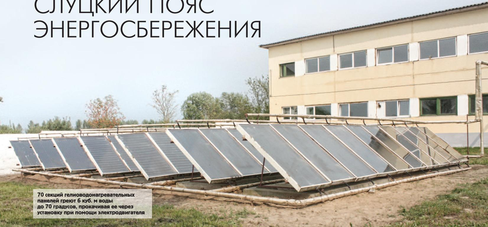
70 секций гелиоводонагревательных панелей греют 6 куб. м воды до 70 градусов, прокачивая ее через установку при помощи электродвигателя
